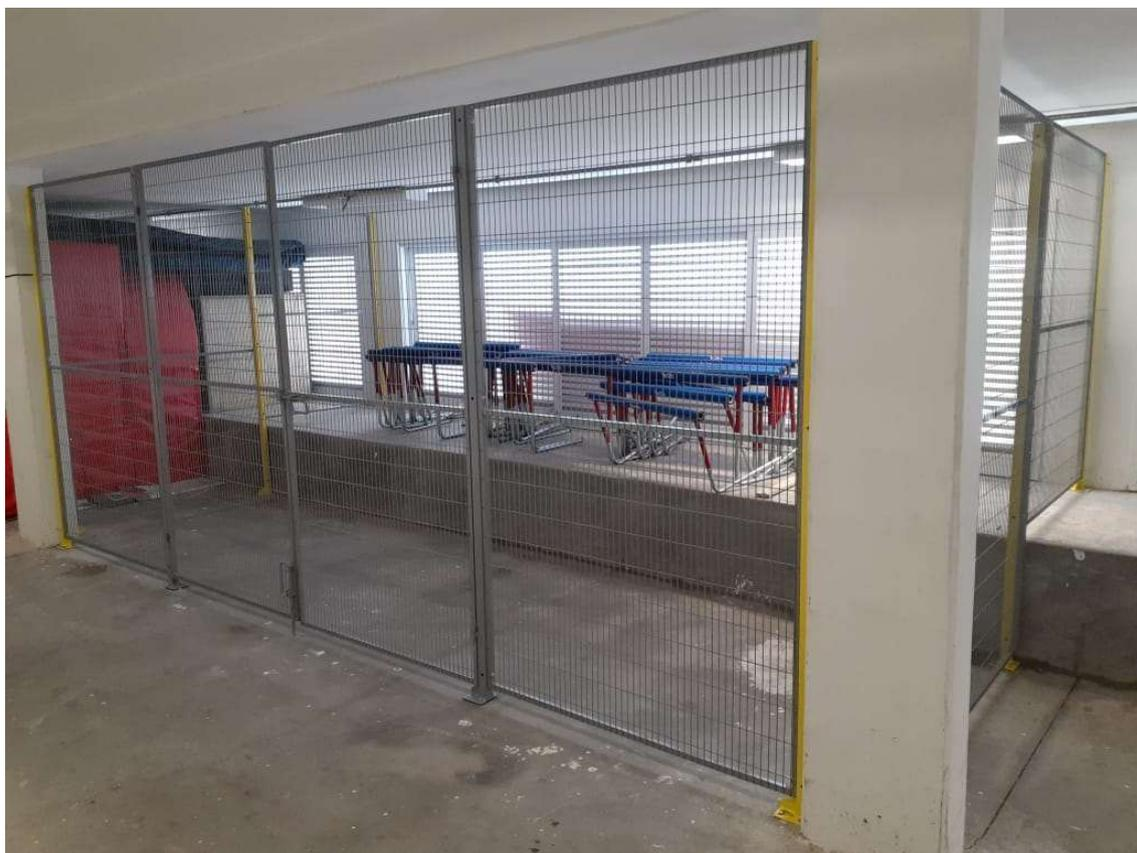
O Sistema de grades modulares é formado por um conjunto de painéis executados em tela malha 22 x 100 mm espessura do fio 3mm, reenquadrado por tubo quadrado de 20 x 20 mm espessura parede 1,20mm com travessa no centro do mesmo material, fixados em colunas montantes em tubo industrial quadrado com tampa inclusa, seção tubular : 40 x 40 mm espessura de parede 2,00mm altura de 2050 mm com sapata de fixação 100 x 150 mm.
